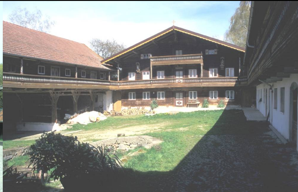
Rottaler Bauernhaus (Wohnhaus) Riedertsham Nr. 9, „Mittermoar“ Gem. Haarbach, Lkr. Passau
