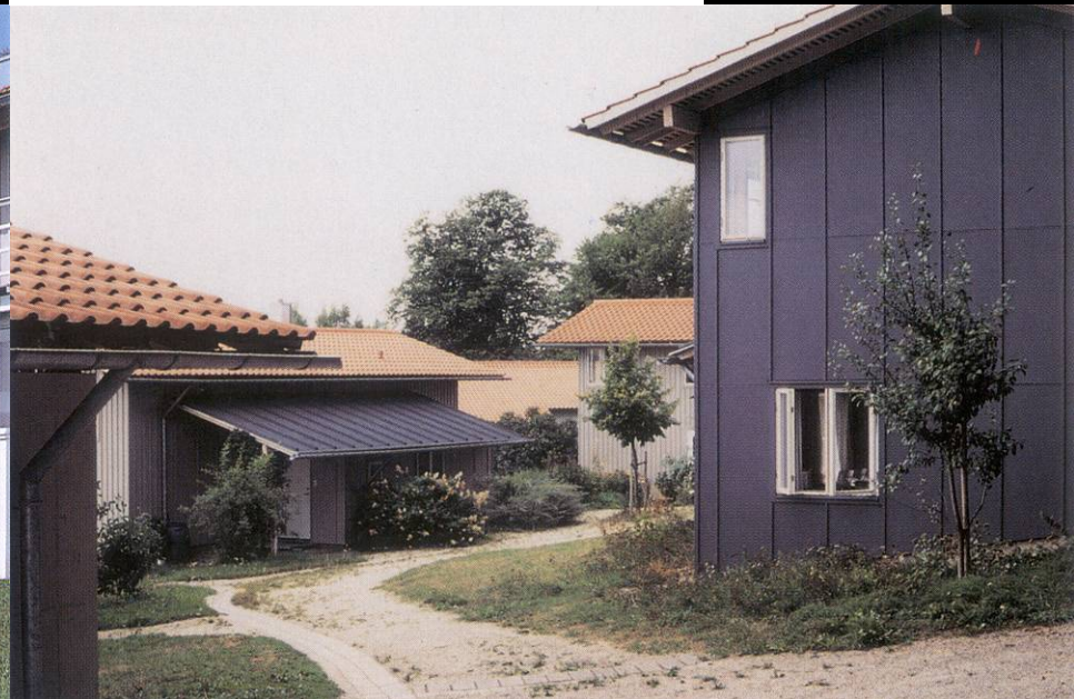
autofreier halböffentlicher Hofraum, Ansicht von Nordosten
